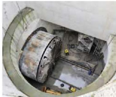
*Puits de sortie du tunnelier pour le prolongement de la Ligne 12 du métro (source : RATP)*
