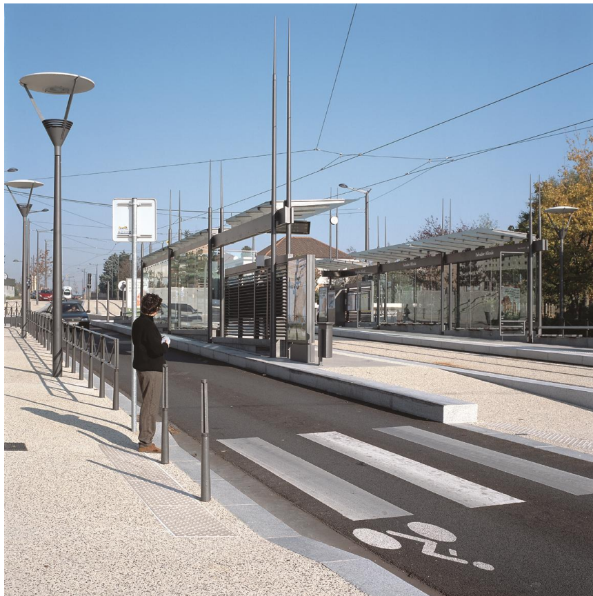
Tramway de Lyon (T2 à Saint-Priest), voirie en zone 30
