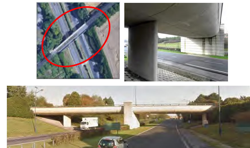
Figure 210 : Ouvrage OA4 franchissant le boulevard du Parc (vue aérienne de localisation, vues depuis le bd du Parc)
