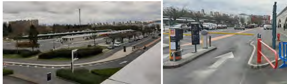
Figure 59 : Vue sur la gare routière Nord et la zone de stationnements adjacente (dépose-minute, taxis, UFR, police/douane, éco-mobilité, livraisons/transport, service « Disney Express ») (SOURCE : ÎLE-DE-FRANCE MOBILITES)
