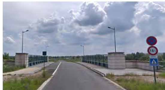
Figure 169 : Ouvrage actuel de franchissement du RER A par la rue de la Charbonnière (pont-route)
