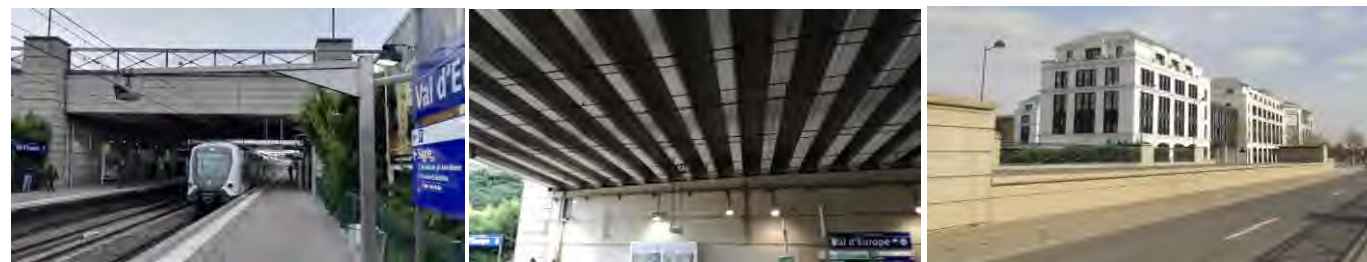
Figure 201 : Vues de l'ouvrage OA1, depuis le quai de la gare RER du Val d'Europe, sous l'ouvrage, et vue du Terre-Plein Central (TPC)
