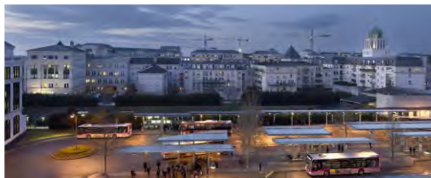
Figure 80 : La gare routière du Val d'Europe dans sa configuration actuelle (SOURCE : EGIS & ÎLE-DE-FRANCE MOBILITES, EPAMARNE/EPAFRANCE)
