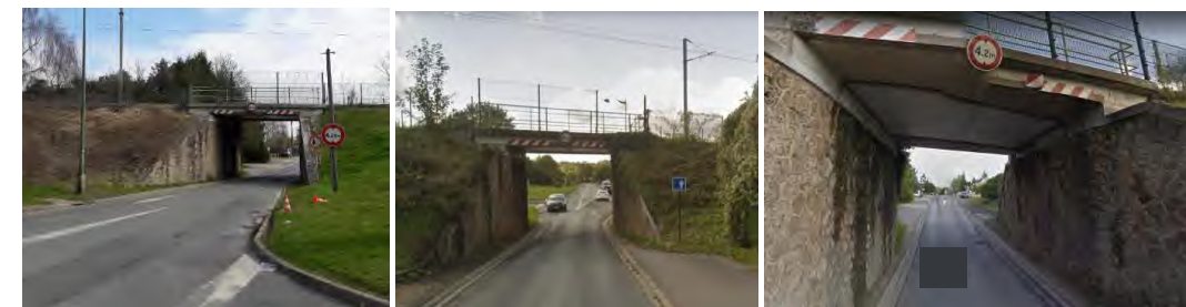
Figure 214 : Vues de l'ouvrage OA5 – Pont-rail franchissant la RD5
