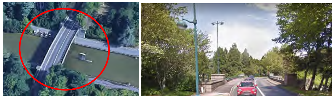
Figure 208: Ouvrage OA3 franchissant la Marina Disney (vue aérienne de localisation et vue depuis l'avenue Schuman)
