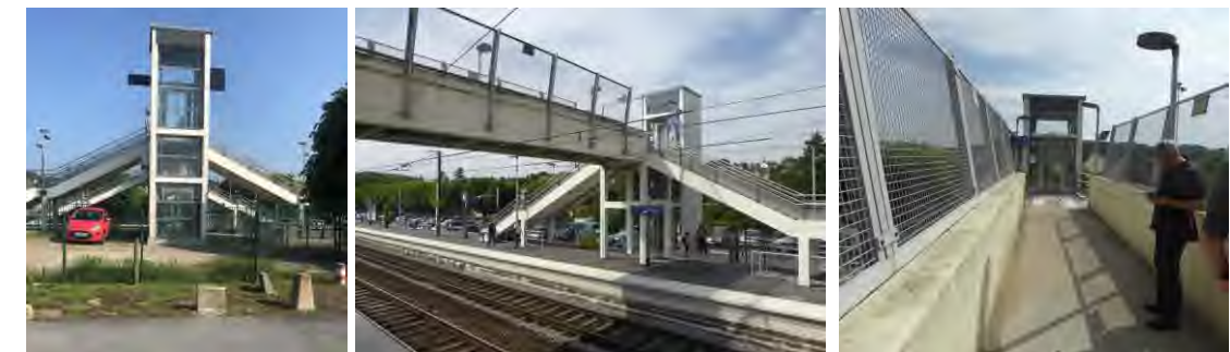
Figure 86 : Passerelle PMR de la gare d'Esbly (SOURCE : EGIS, 2017-2019)
