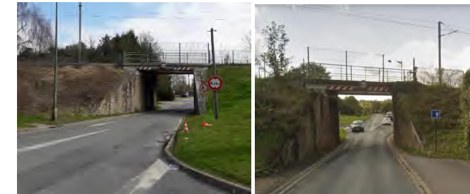
Figure 181 : Vues de l'ouvrage OA6 actuel – Pont-rail franchissant la RD5 (alternat routier) (SOURCE : GROUPEMENT EGIS/ GAUTIER-CONQUET, 2019)
