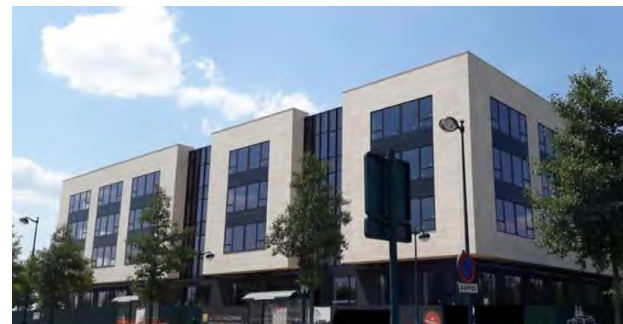
Figure 35 : ZAC du Pré au Chêne à Jossigny : hôpital intercommunal de Marne La Vallée et travaux du projet Carré Haussmann Marne La Vallée (SOURCE : EGIS, 2017 - 2018)
