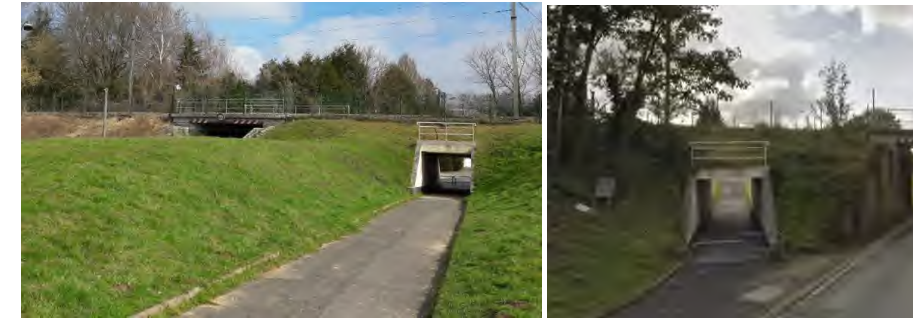
Figure 213 : Vues de l'ouvrage OA5 – passage modes actifs
