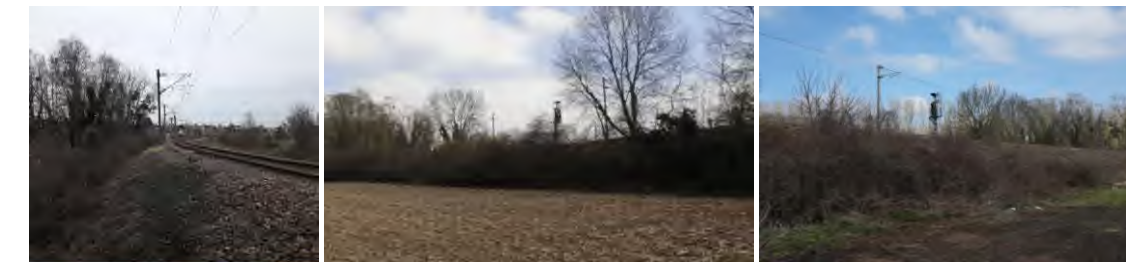
Figure 218 : Vues d'une partie du talus ferroviaire de la ligne Esbly-Crécy-la-Chapelle (sur le talus ferroviaire, et depuis l'Est et l'Ouest du talus)
