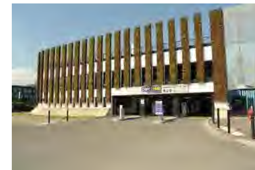
Figure 58 : Accès au parking-relais situé à proximité de la gare RER du Val d'Europe via la rue de la Charbonnière (SOURCE : SAEMES)
