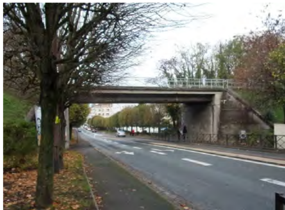
Figure 33 : Pont rail de la Grande Ceinture depuis la RD 190
