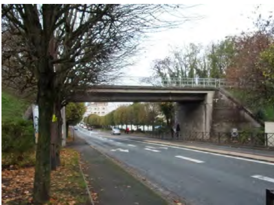
Figure 36 : ouvrage existant de la RD 190
