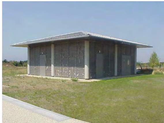
Figure 20 : Local à sous-station électrique
