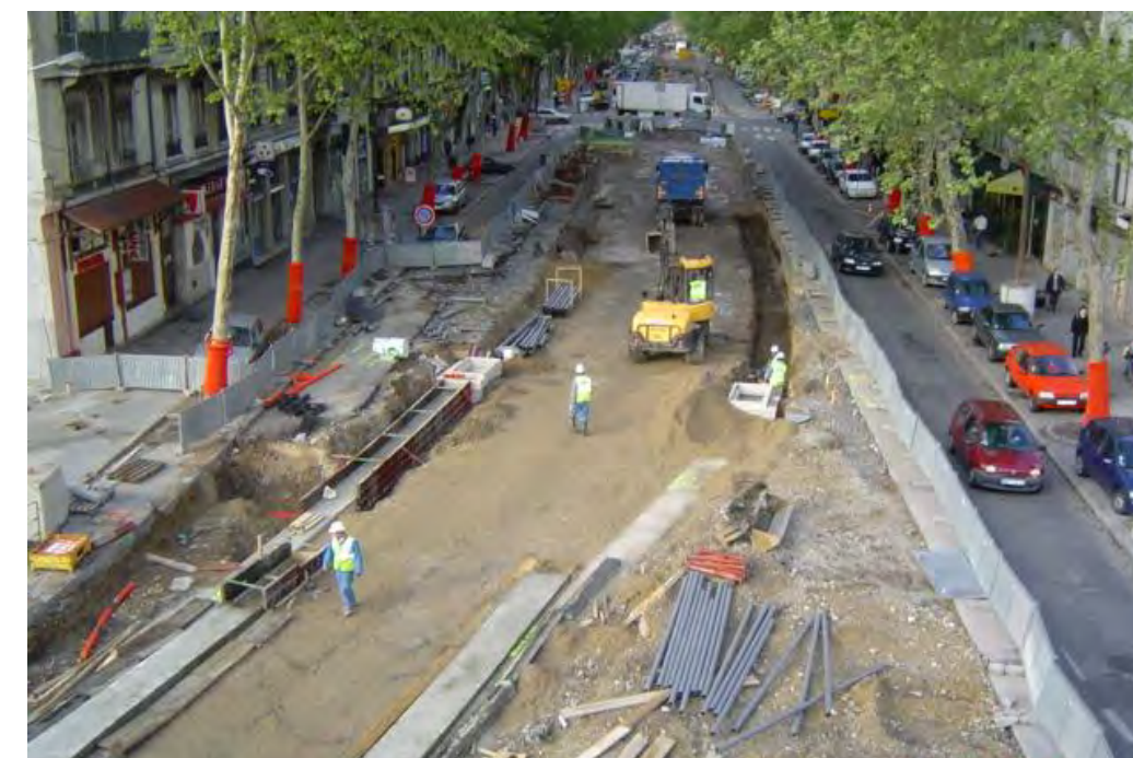
Figure 11 : Travaux de terrassement pour l'aménagement d'une ligne de tramway
