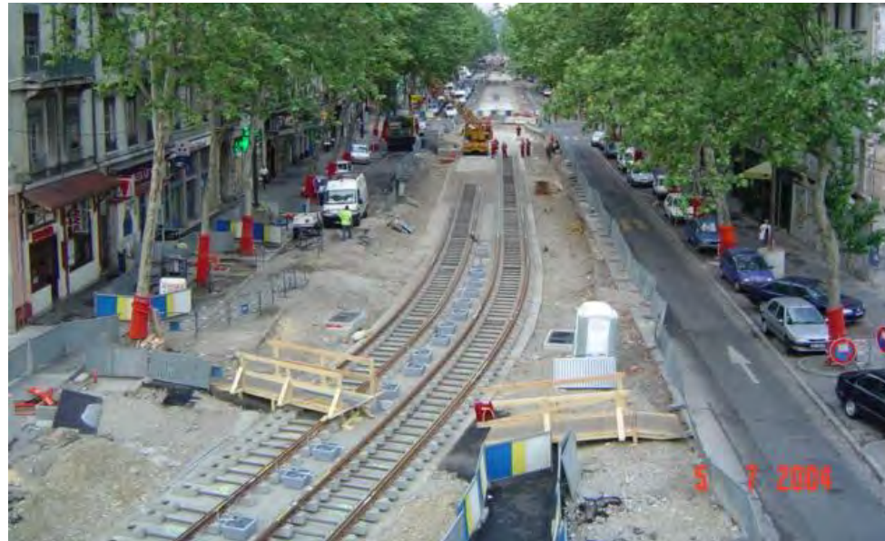
Figure 17 : Mise en place des rails
