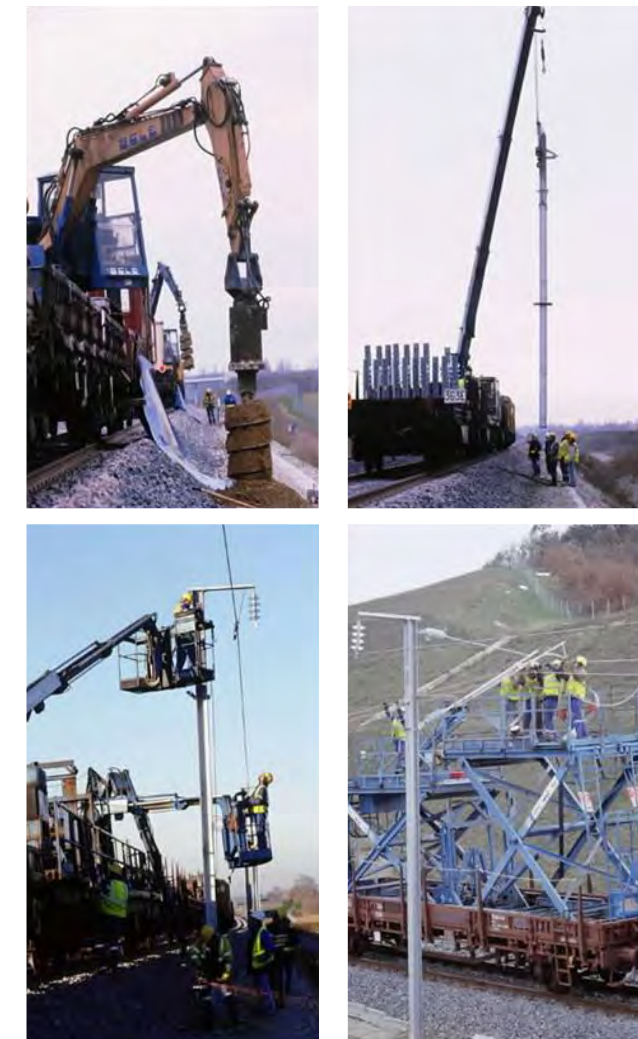
Figure 19 : Les différentes étapes de pose de la LAC
