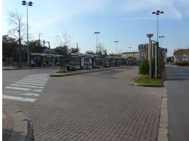
Figure 252 : Gare routière sud et gare routière nord (extrait du DOCP Pôle de Poissy)
