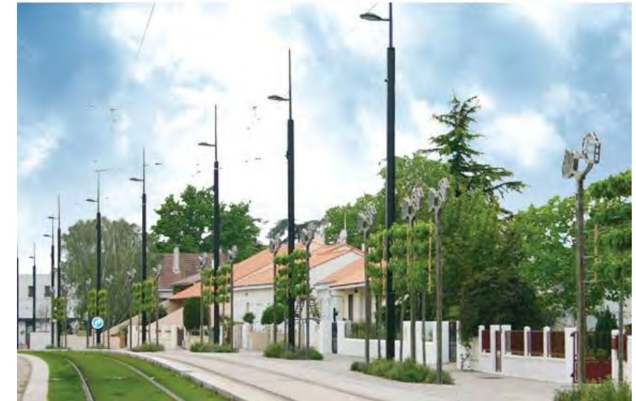
Figure 179 : Exemple de mutualisation de supports LAC et d'éclairage, tramway Nantes.
