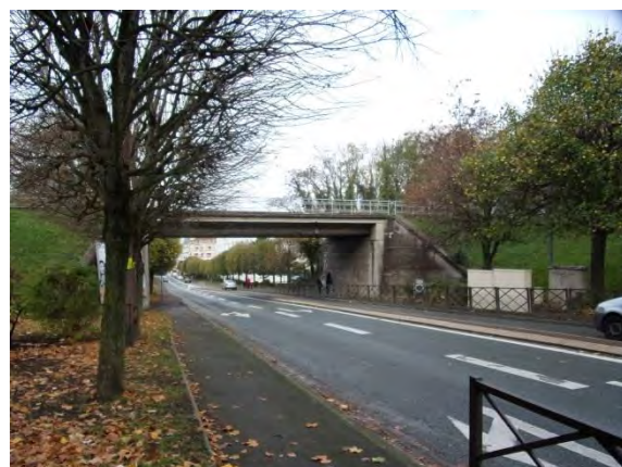
Figure 215 : Ouvrage existant de la RD 190
