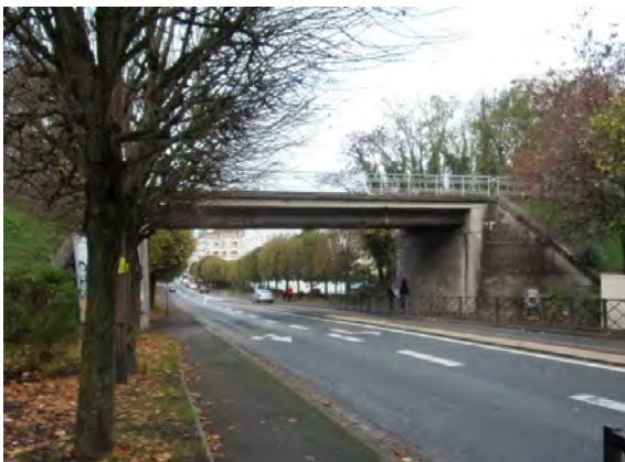
Figure 107 : ouvrage existant de la RD 190
