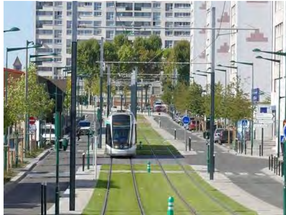
Figure 183 : Exemples de revêtement végétalisé, Tramway T3 à Paris Source : www.paddlesteamers.info
