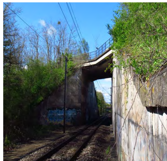
Figure 224 : Pont en béton armé du saut de mouton
