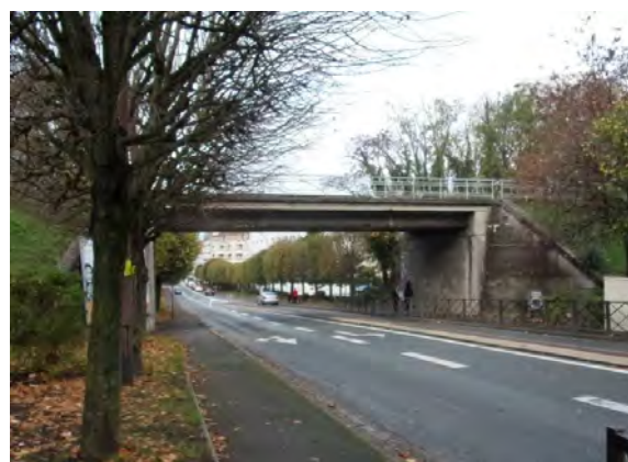
Figure 140 : Pont rail de la Grande Ceinture depuis la RD 190
