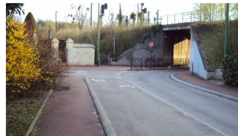
Figure 228 : Pont-rail d'Achères Ville (Avenue de Conflans) à élargir
