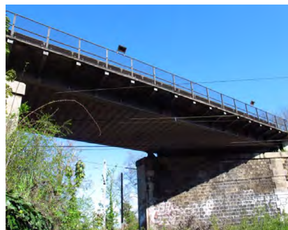
Figure 223 : Pont métallique du saut de mouton
