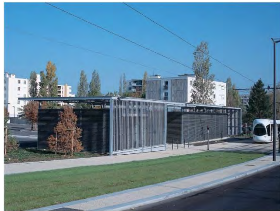
Figure 188 : Exemple de traitement de façade pour un local à sous station
