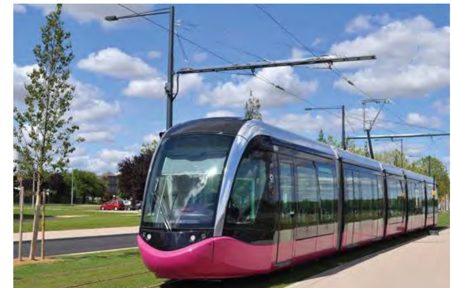
Figure 180 : Exemple de mutualisation de supports LAC et d'éclairage, tramway Dijon.
