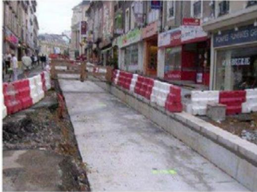
Figure 8 : Cheminement piétons préservés pendant le chantier du tramway du Mans
