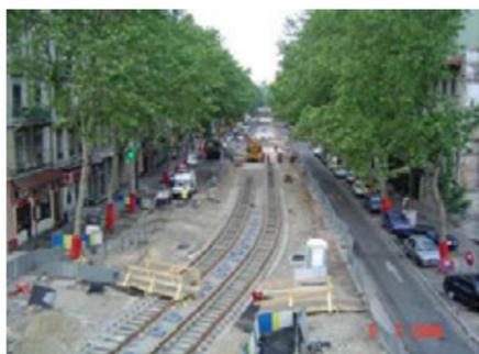
Figure 11 : Mise en place des rails
