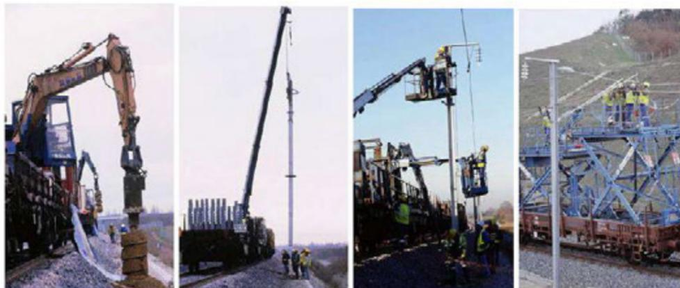
Figure 14 : les différentes étapes de pose de la LAC
