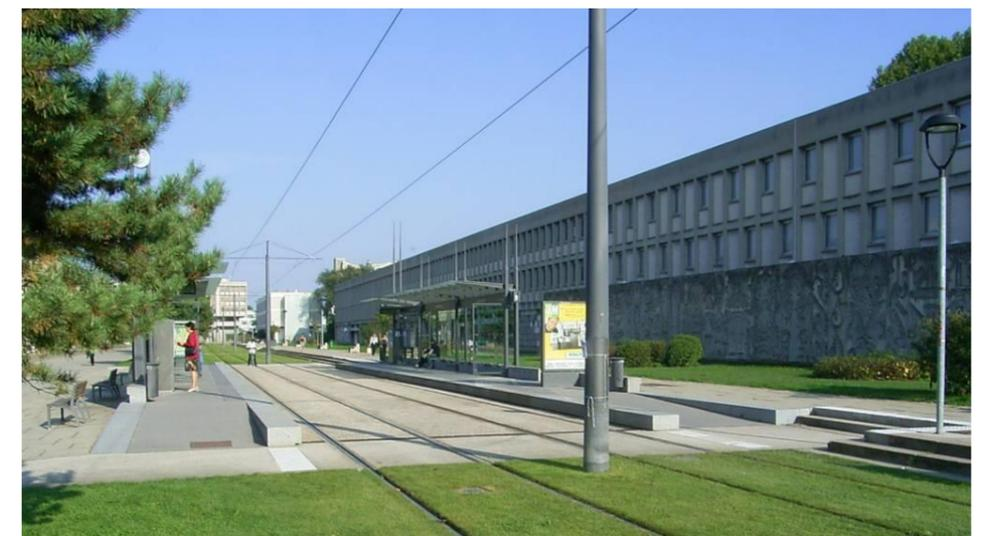
Figure 23 : Exemples de traversées piétonnes en station à niveau en urbain
