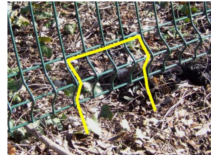
Figure 11 : Exemple de maille à ouvrir en pied de clôture du RFN pour faciliter le passage de la petite faune
