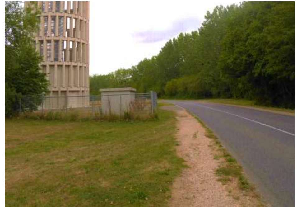
Figure 74 - Photographie du boulevard des Maréchaux Est au droit du radar de l'Aviation Civile de Palaiseau
