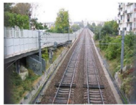
Figure 42 : Section rénovée à travers béton à hauteur de Saint-Germain-en-Laye (RN13 - Bel Air)
