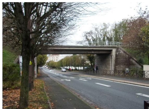
Figure 6 : Pont rail de la Grande Ceinture depuis la RD 190
