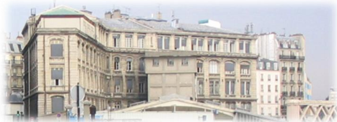
Niveau « Haut » - Vue arrière du bâtiment et de l'ancien tri postal
