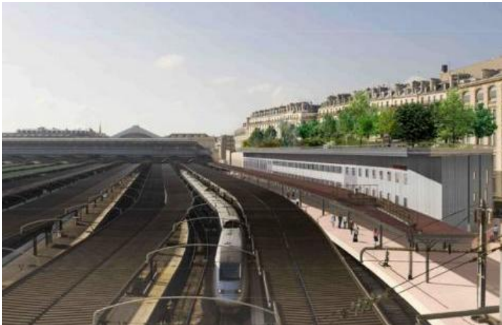
Figure 30 : Vue depuis la rue La Fayette des voies de la Gare de l'Est et sur le projet Balcon Vert
