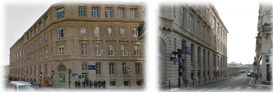
Niveau « Haut » - Vue avant / entrée du bâtiment depuis l'angle des rues La Fayette et Alsace
