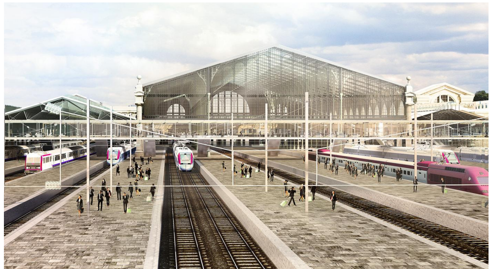
Figure 29 : La passerelle au dessus des voies ferrées (Agence Wilmotte, 2015)
