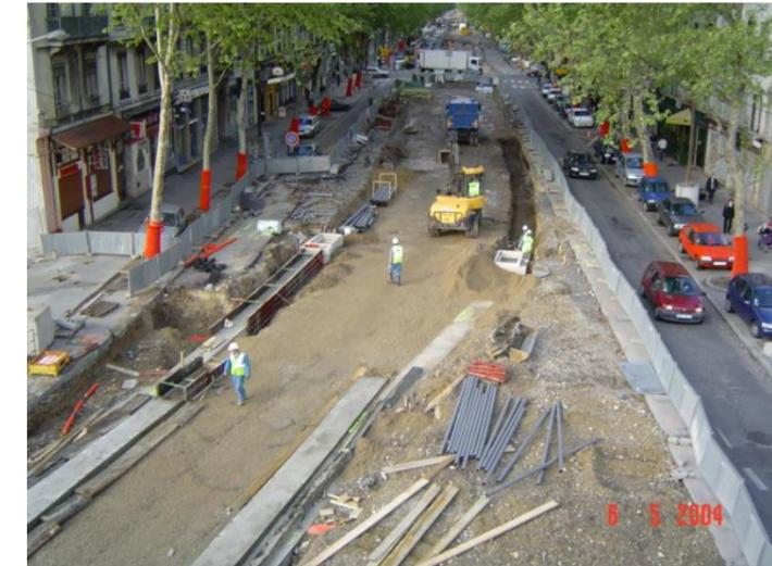
Figure 7 : Travaux de terrassement pour l'aménagement d'une ligne de tramway
