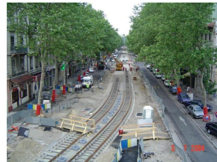
Figure 8 : Mise en place des rails
