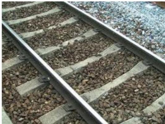
Figure 3 : Traverses béton d'une voie de chemin de fer
