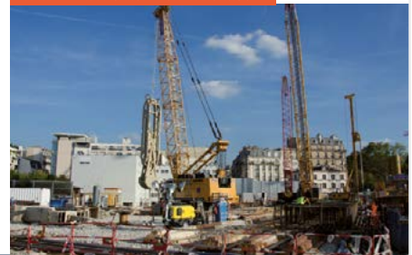
EXEMPLE DE RÉALISATION D'UNE PAROI MOULÉE
