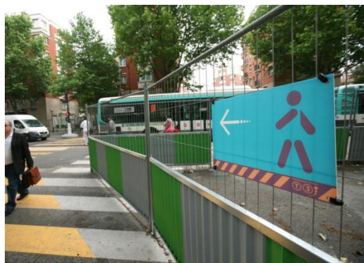
Figure 30 : Signalisation provisoire en bordure de chantier pour guider les piétons
