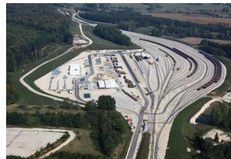
Figure 2 : Base travaux sur la ligne LGV Est
