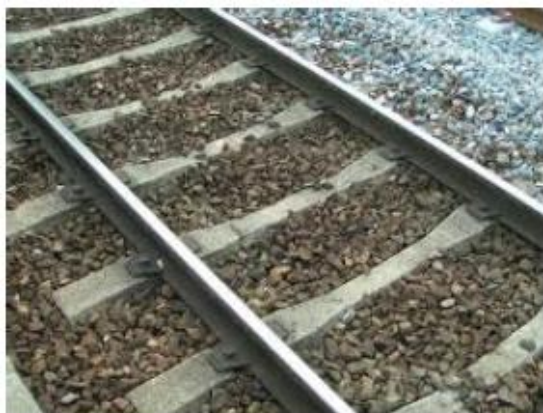
Figure 5 : Traverses béton d'une voie de chemin de fer
