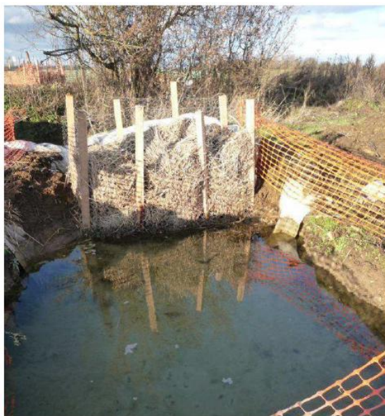
Figure 22 : Filtre à paille en sortie d'un bassin de décantation
