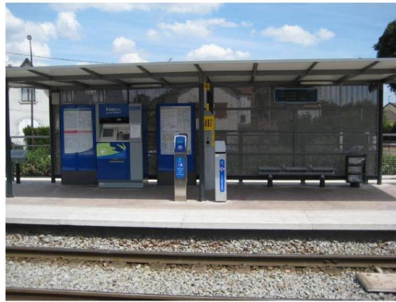
Figure 18 : Station sur T4 – Aulnay-Bondy
