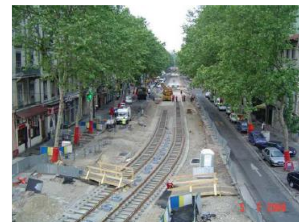
Figure 7 : Mise en place des rails
