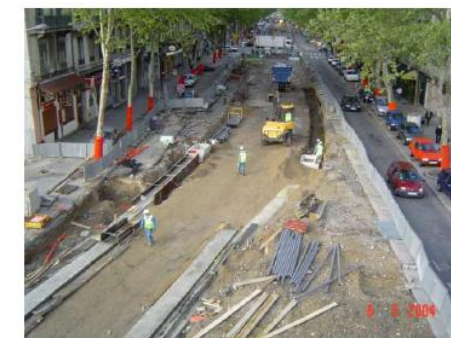
Figure 6 : Travaux de terrassement pour l'aménagement d'une ligne de tramway
