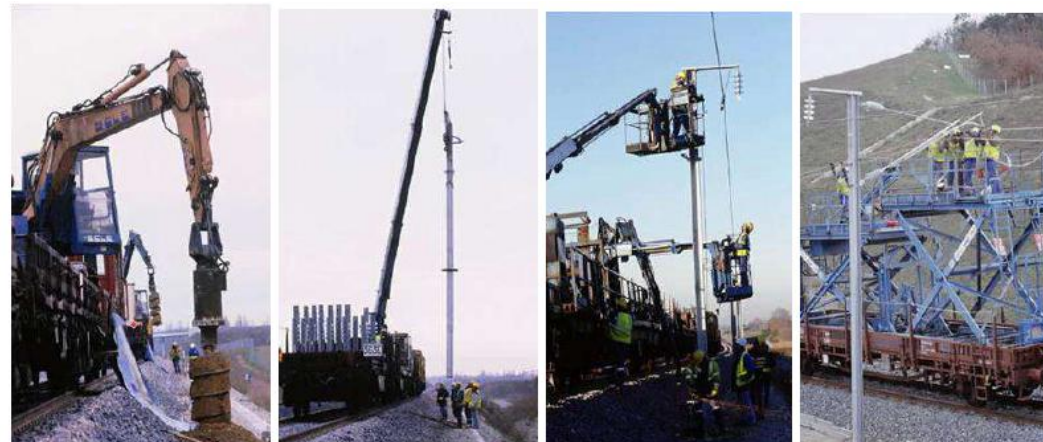
Figure 10 : les différentes étapes de pose de la LAC Source : étude d'impact sur l'environnement TTNC
