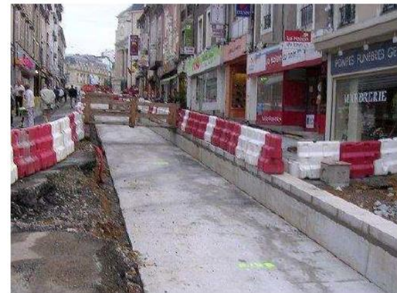
Figure 1 : Cheminement piétons préservés pendant le chantier du tramway du Mans
