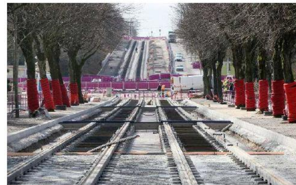
Figure 9 : Travaux de construction de la plateforme du Tramway – Dijon Source : Egis Rail
