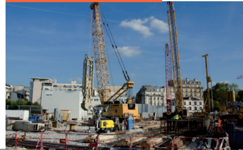
EXEMPLE DE RÉALISATION D'UNE PAROI MOULÉE
