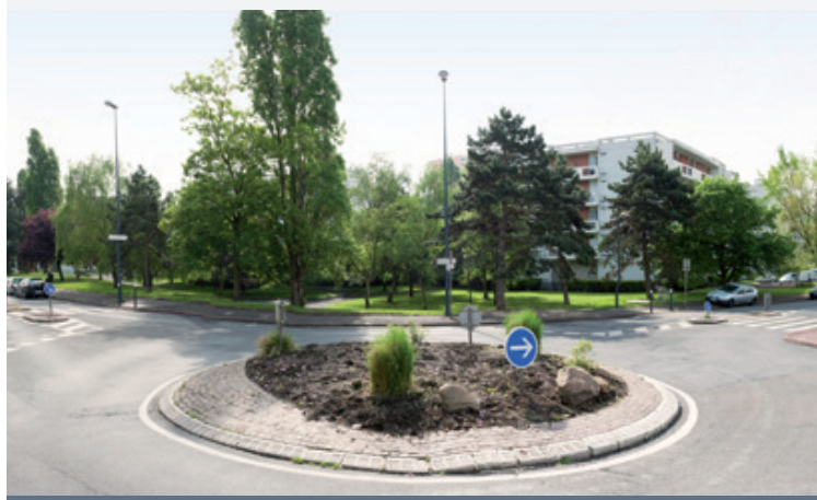
Carrefour rue Fontaine et rue Jean-Pierre Timbaud, Fontenay-sous-Bois
