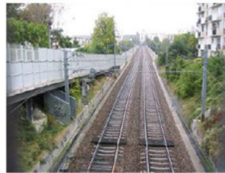
Figure 39 : Section rénovée à travers béton à hauteur de Saint-Germain-en-Laye (RN13 - Bel Air)
