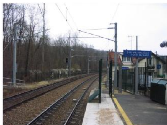
Figure 24 : Photographie des quais de la GCO - Saint-Nom-la-Bretèche
