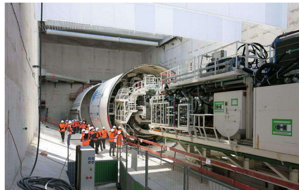
Figure 33 – Inauguration du tunnelier Magaly, qui a creusé la première partie du prolongement nord de la Ligne 14 entre Saint-Lazare et Mairie de Saint-Ouen (Source : Le Parisien)
