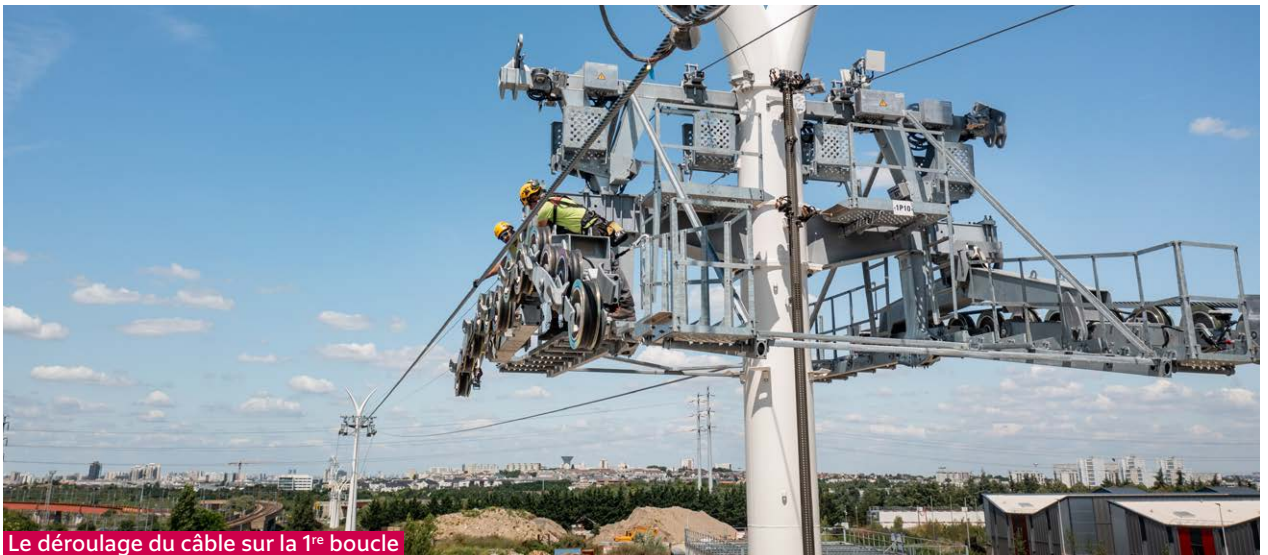
Le déroulage du câble sur la 1 re boucle
