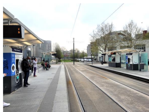
Figure 9 - Exemple de stations (Tramway T8, station Pablo Neruda à Villetaneuse)
