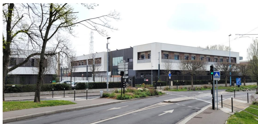
Figure 11 - Exemple de Site de maintenance et de remisage (Tramway T8, Villetaneuse)
