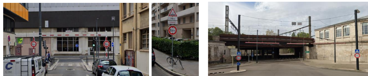
Figure 119 - Exemple de portiques de limitation de gabarit (type G3) (cours Lafayette à Lyon – gauche, boulevard de Sévigné à Dijon - droite)
