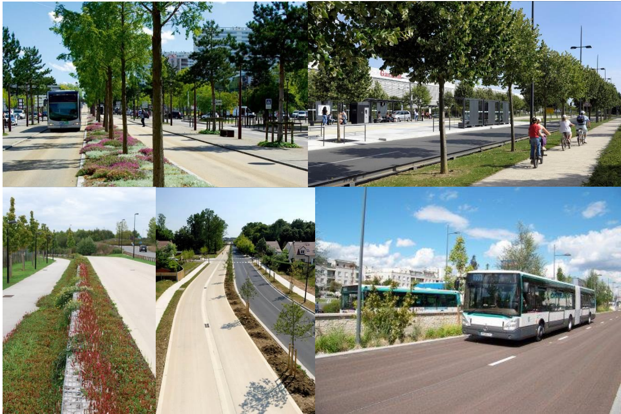
Exemples d'aménagements paysagers le long de la plateforme en site propre bus
