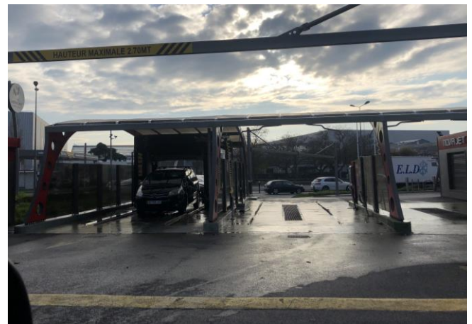
Station de lavage à démolir rue des Quinze Arpents
