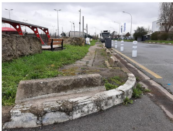
Rue des 15 arpents (Ile-de-France Mobilités) - Mise en évidence des conditions de franchissement des accès riverains
