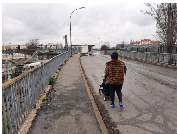
Voie d'accès au pôle d'échanges du Pont de Rungis (Ile-de-France Mobilités)
