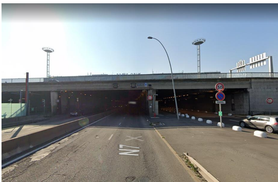
Entrée de la RD7 sous l'aéroport d'Orly (Source : Google Maps)
