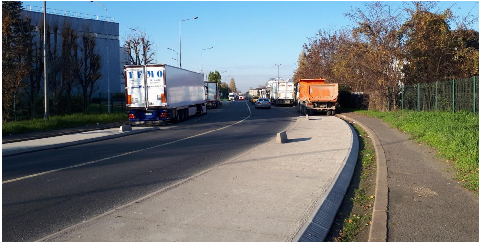
Terre-plein empêchant le stationnement des poids-lourds dans un virage (Source : Systra)
