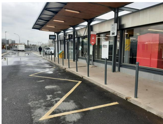
Gare du Pont de Rungis (Ile-de-France Mobilités) - les points d'arrêt desservant la gare du Pont de Rungis ne permettent pas une accessibilité satisfaisante aux PMR
