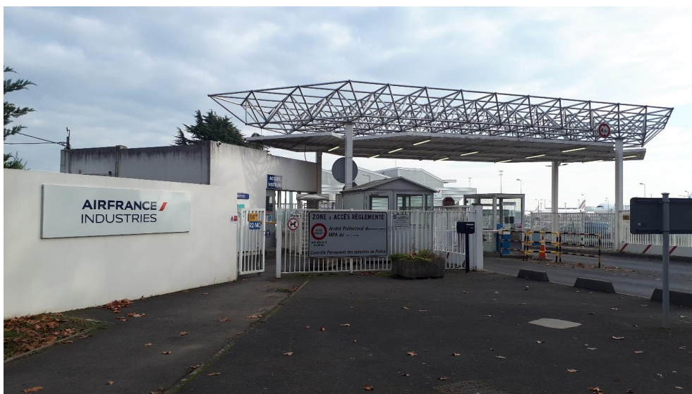
Exemple de stationnement privé sur du foncier ADP (Source : Systra)
