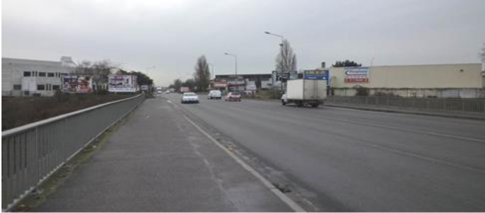
Ouvrage de franchissement des voies ferrées rue du Bas Marin
