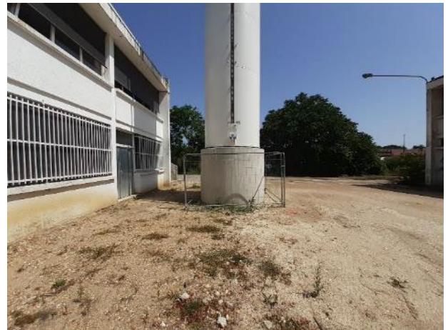
Pylône 4P3 au sein de la BSPP © Ile-de-France Mobilités
