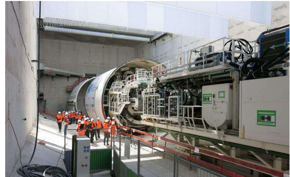
Figure 73 – Inauguration du tunnelier Magaly, qui a creusé la première partie du prolongement nord de la Ligne 14 entre Saint-Lazare et Mairie de Saint-Ouen (Source : Le Parisien)
