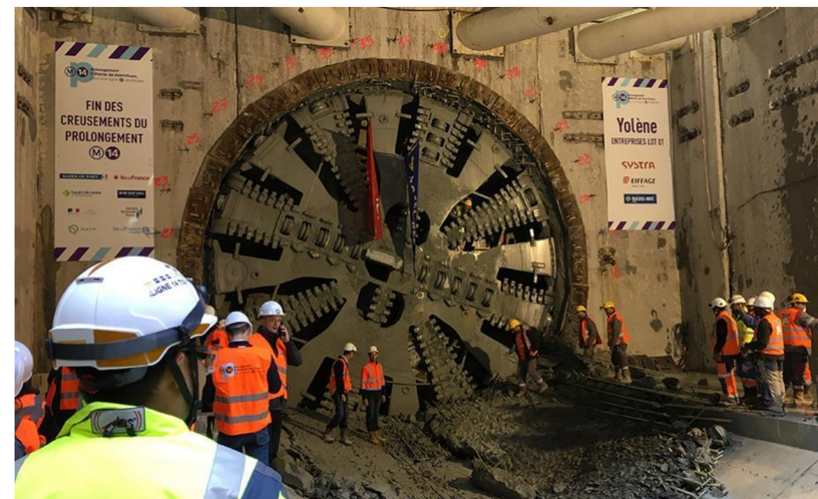
Figure 74 – Fin des creusements du second tunnelier Yolène entre Pont Cardinet et Clichy Saint-Ouen (Source : Eiffage)
