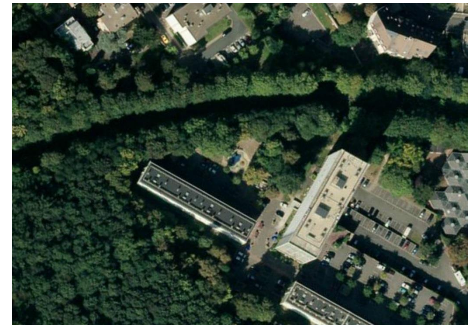
Figure 278 : Vue aérienne des immeubles situés à proximité de l'avenue Fernand Lefebvre à Poissy
