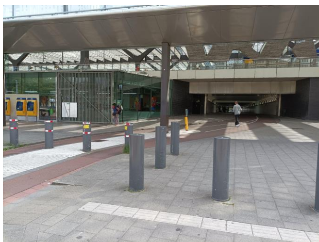
Entrée nord de la piste cyclable sous les voies ferrées Gare centrale de Rotterdam (Photo : Jean-François Pierre)
