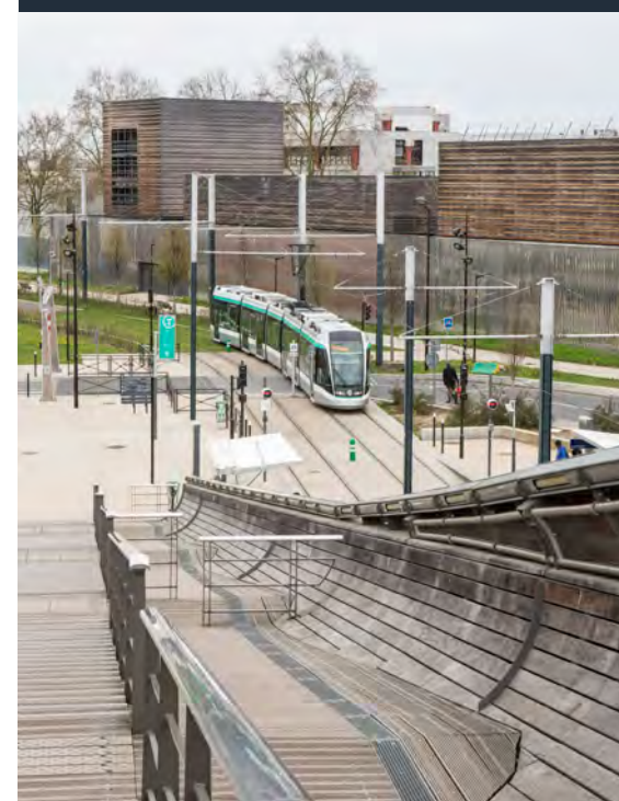
Vue de la station du tram T8 à Villetaneuse-Université
