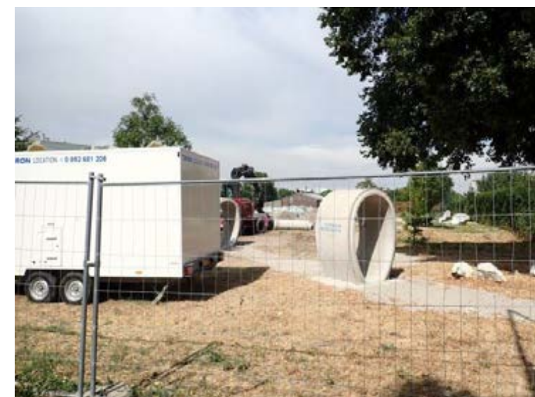
Figure 104 – Travaux en 2020 sur la pelouse située sur l'entité « Grands Pêchers » (Source : EGIS)
