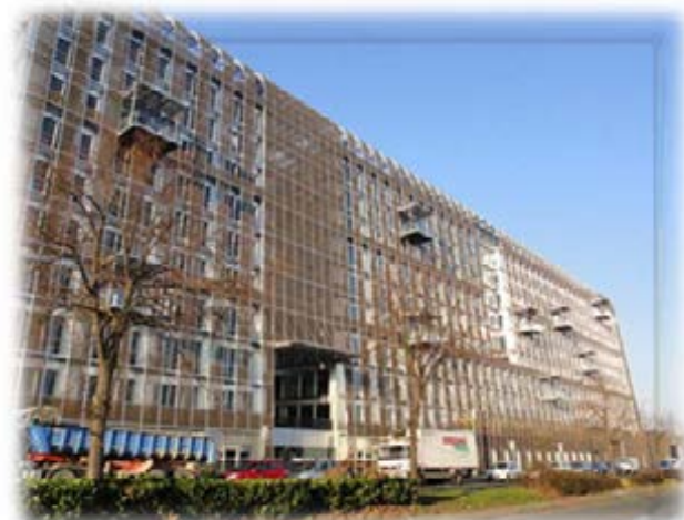
Figure 197 – Campus Société Générale, livré à l'automne 2016 (Sources : IDFM / EGIS)
