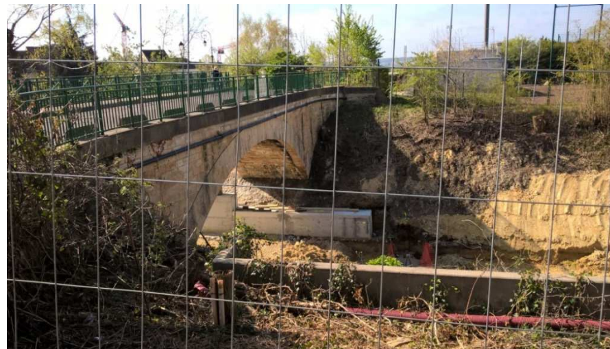
Confortement PRO Chemin des princes
