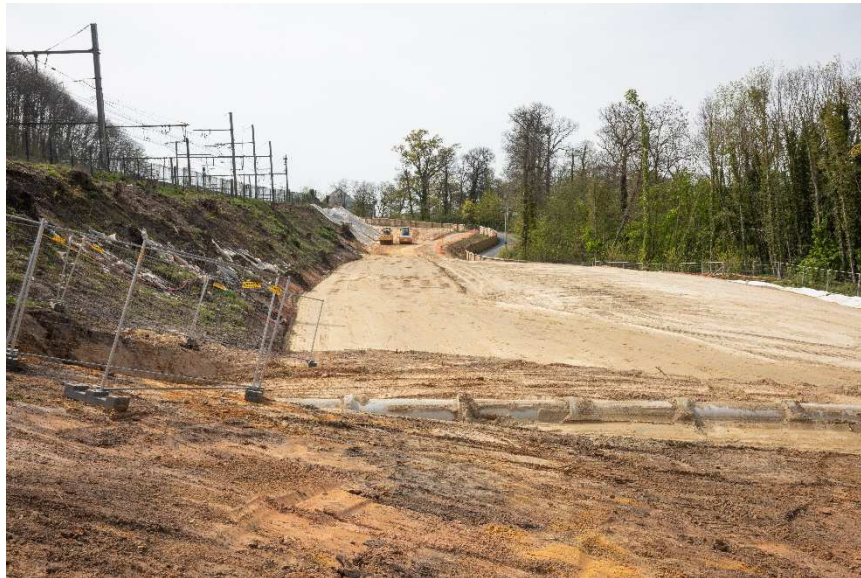
Opération de montage du remblai ECOSOL adossé au talus du RFN
