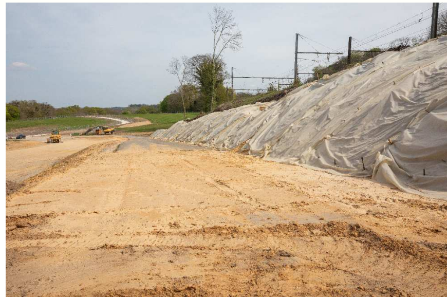
Opération de montage du remblai ECOSOL adossé au talus du RFN
