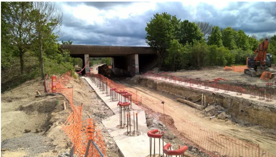
Confortement – décaissement / PRO A12
