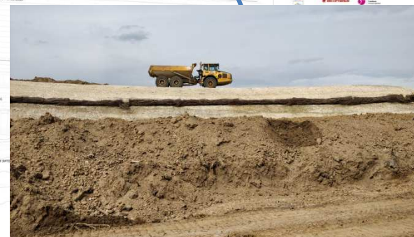
Mise en œuvre des terres sur le merlon paysager en vue de la plantation des arbres
