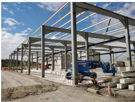
Montage de la charpente de l'atelier
