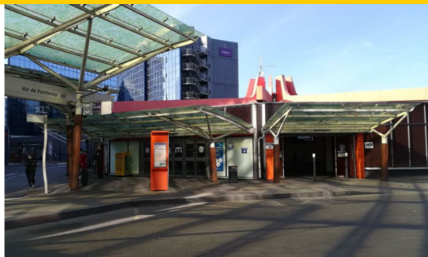
Bâtiment voyageurs de la gare de Val de Fontenay (Source : Egis)
