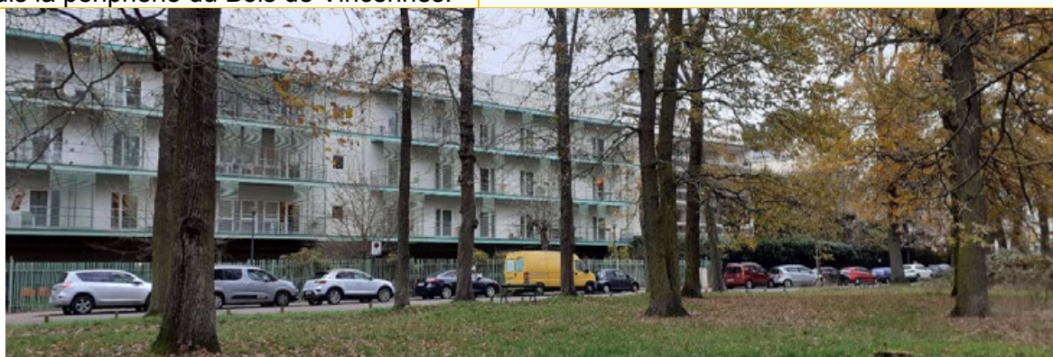
4.3. Vue sur la maison de retraite intercommunale (bâtiment R+3 avec une façade de 55 m de long).
