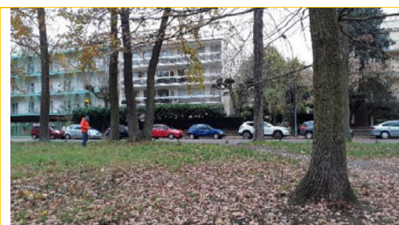
4.1. Vue sur la maison de retraite intercommunale et un immeuble mitoyen, depuis la périphérie du Bois de Vincennes.
