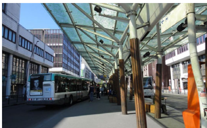
Avenue du Val de Fontenay – vue sur le pôle bus (Crédit : Egis)
