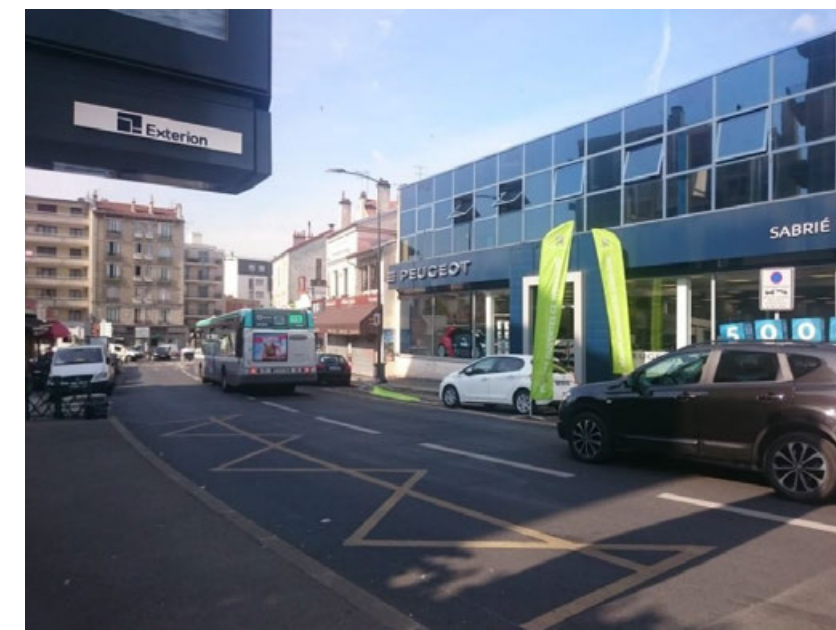
Avenue de la République menant au carrefour des Rigolots – vue côté sud – Garage Peugeot (Crédit : INGEROP)
