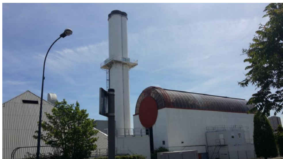
Figure 216 – RCU de Fontenay-sous-Bois
