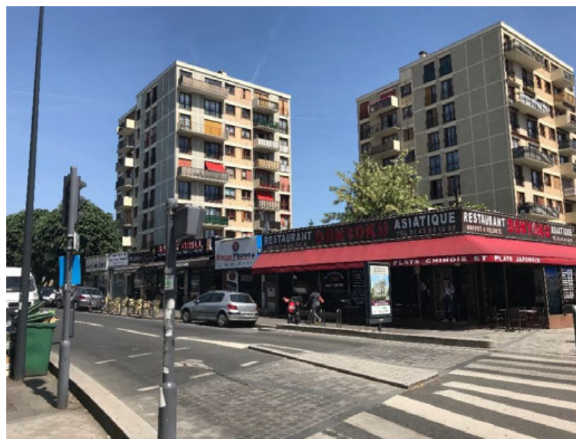
Avenue de la République – Grands ensembles (Crédit : INGEROP)
