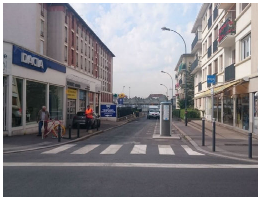
L'atelier de maintenance des trains de la RATP au sud de la rue Dalayrac – vue sur la rue Eugène Martin (Crédit : INGEROP)
