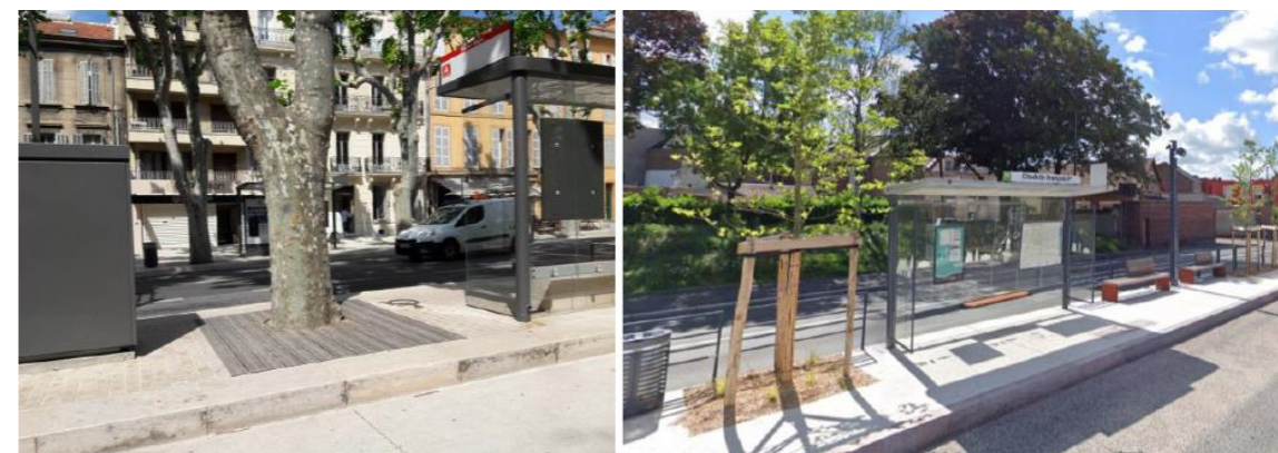
Figure 104 - Exemple de quais de station bus plantés : station Victor Hugo à Aix-en-Provence (gauche) et station Citadelle François 1 er (Amiens)
