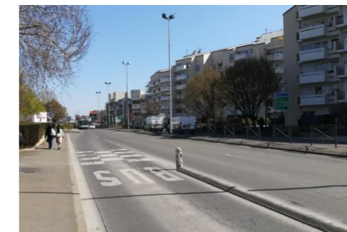
Avenue du Général de Gaulle (ex-RN34) – Neuilly-sur-Marne Site propre unidirectionnel latéral dans le sens vers Paris Source : Egis, 2021
