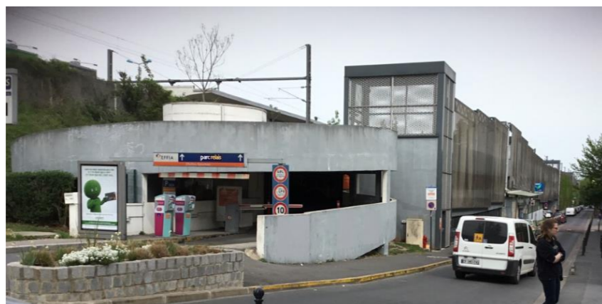
Figure 53 - Parc-relais de Chelles (Source : Egis, 2019)
