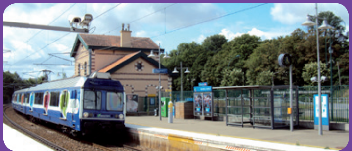
Station actuelle de la Grande Ceinture Ouest – Mareil-Marly
