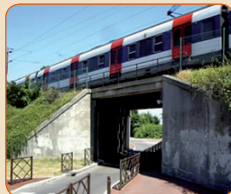
Pont-rail Achères Ville (Avenue de Conflans)
