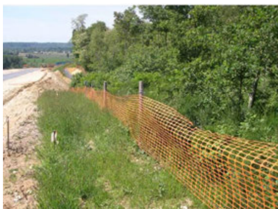
Figure 24 : Balisage physique du chantier (IEA)
