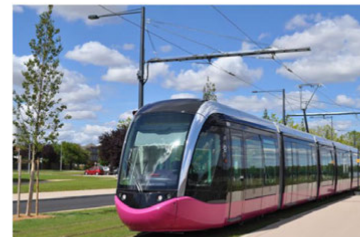
Figure 43 : Exemple de mutualisation de supports LAC et d'éclairage, tramway Dijon.
