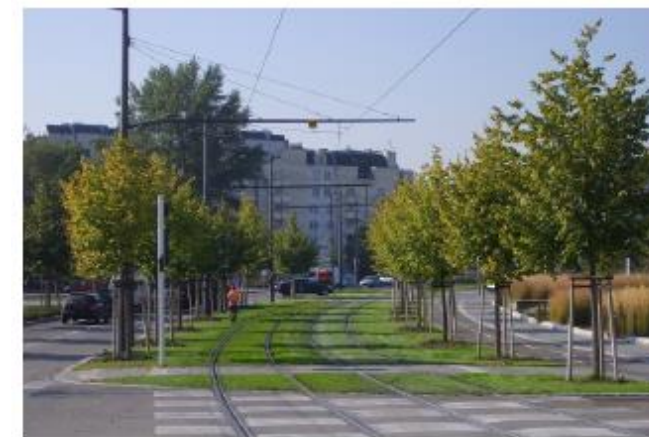
Figure 47 : Exemples d'aménagement de plateforme tramway
