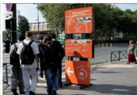
Figure 37 : Panneaux de signalisation des cheminements piétons et d'informations sur le chantier du tramway T3
