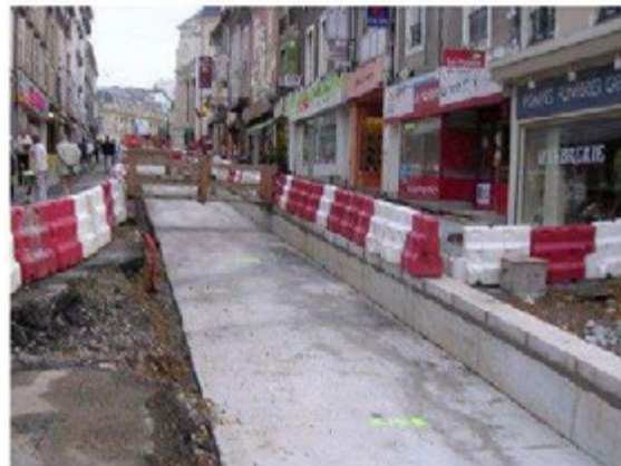
Figure 16 : Cheminement piétons préservés pendant le chantier du tramway du Mans
