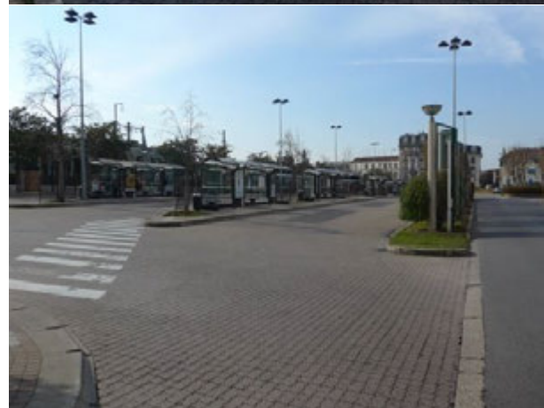
Figure 68 : Gare routière sud et gare routière nord (extrait du DOCP Pôle de Poissy)
