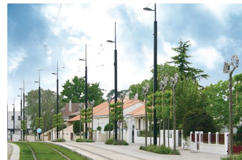
Figure 103 : Exemple de mutualisation de supports LAC et d'éclairage, tramway Nantes.
