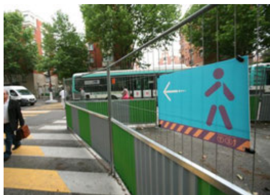
Figure 19 : Signalisation provisoire en bordure de chantier pour guider les piétons
