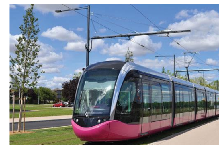
Figure 104 : Exemple de mutualisation de supports LAC et d'éclairage, tramway Dijon.
