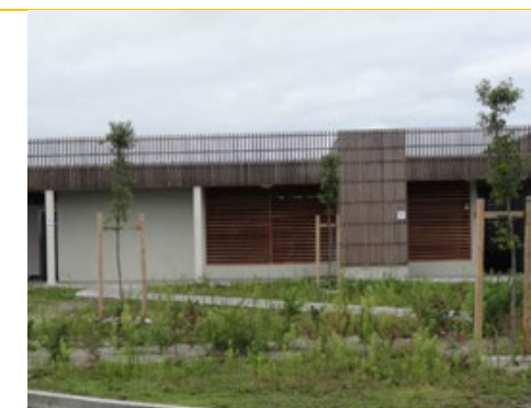
Figure 110 – Façade en lames bois ajourées – Aire de services de Labouheyre
