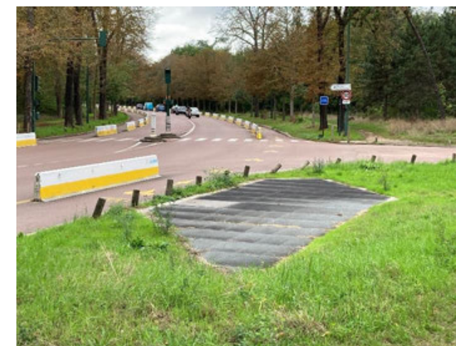
Figure 53 – Exemple de grille de ventilation de la Ligne 1 existante, située dans le Bois de Vincennes avenue de Nogent (Source : IDFM)
