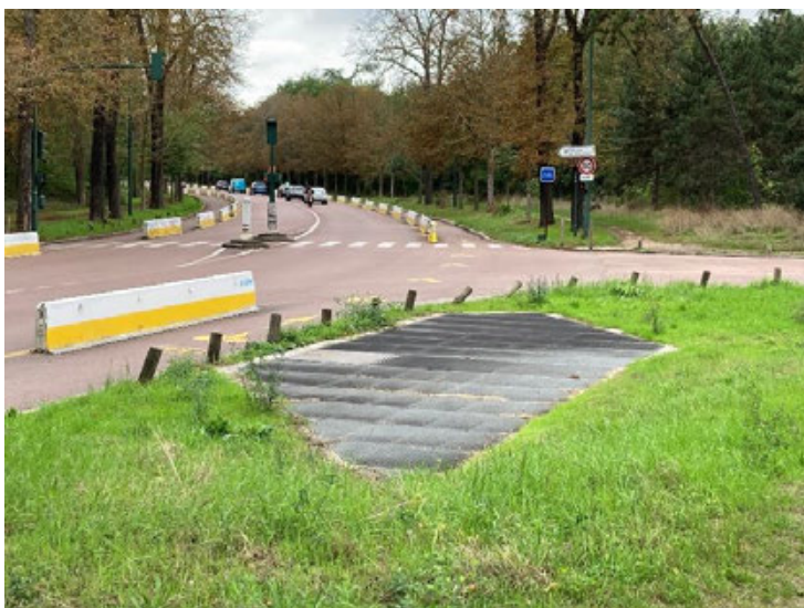
Figure 85 – Grille de ventilation existante de la Ligne 1 située dans le Bois de Vincennes
