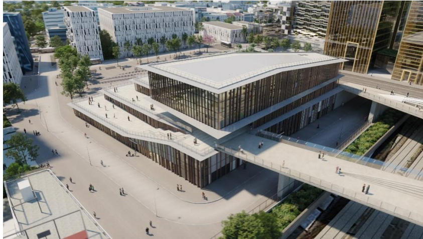
Vue de la future station de métro Saint-Denis Pleyel sur la ligne 14 © Société du Grand Paris / Agence Kengo Kuma & Associates
