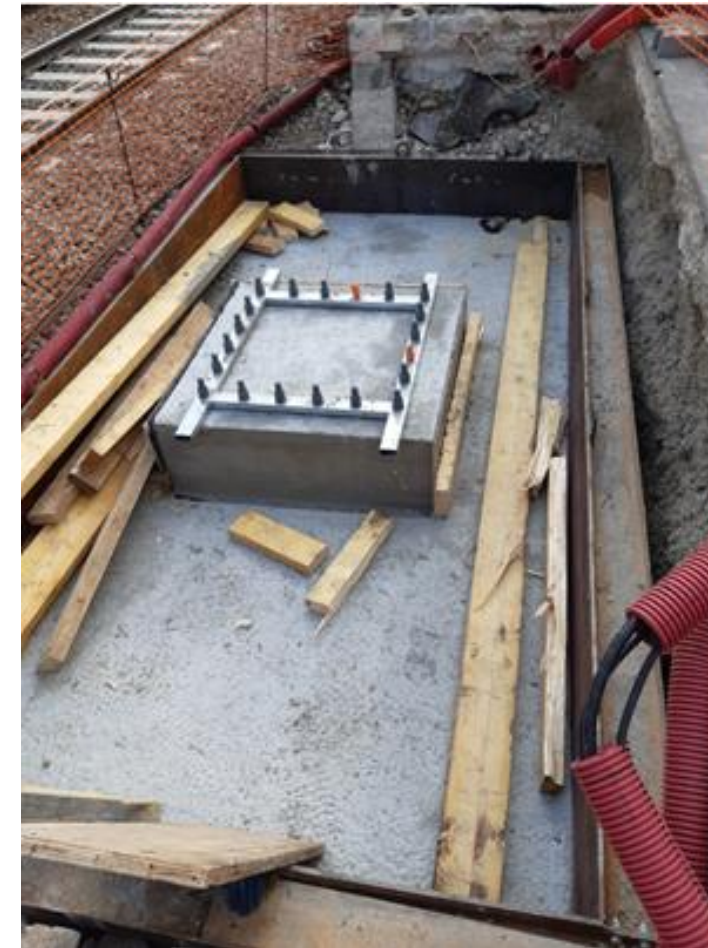
Déplacement d'une potence de signalisation (Gare de Sèvres Rive Gauche)
