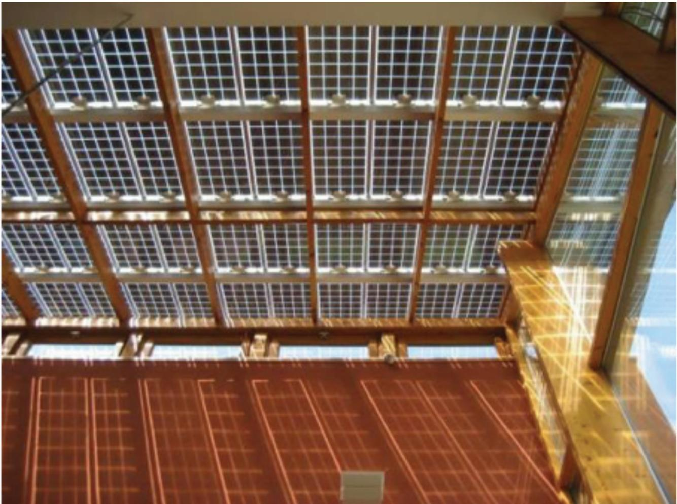
Figure 11 - Exemple de cellules PV bi-verre
