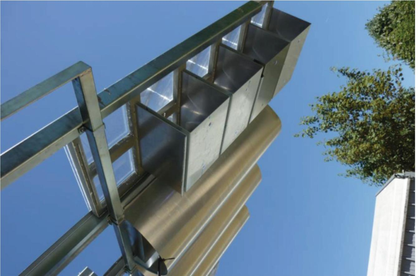
Figure 10 - Exemple de mât d'éclairage naturel
