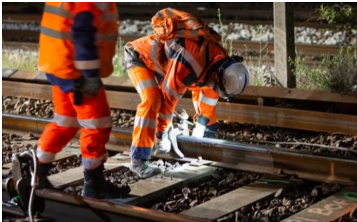
Ex: graissage d'un appareil de voie, remplacement d'une traverse
