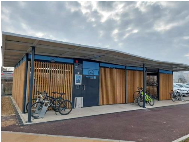
Parking Vélos de Montereau, mis en service en mars 2023
