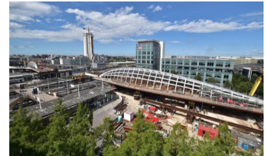
Ex : FUP, passerelle Charenton Bercy, passage des tunneliers SGP
