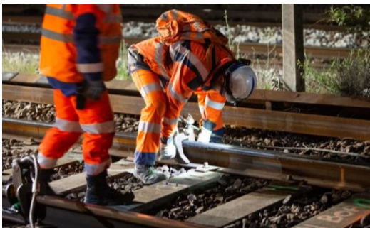
Ex: graissage d'un appareil de voie, remplacement d'une traverse
