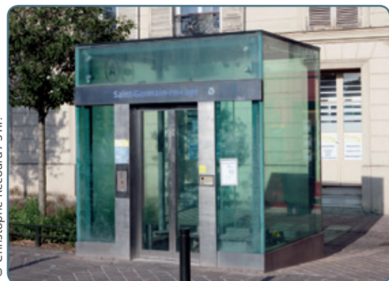
Ascenseur reliant la voirie aux quais en gare de Saint-Germain-en-Laye (78).
