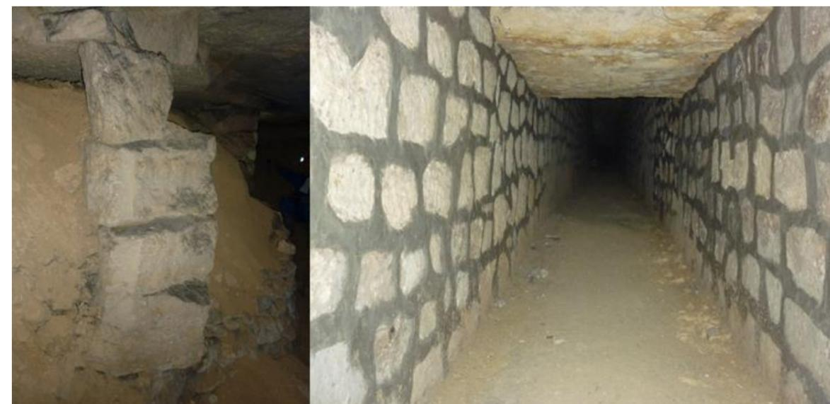
Ponctuellement, les carrières souterraines ont été consolidées (en particulier au droit des bâtiments, dont le PC est soumis à des recommandations émises par l'Inspection Générale des Carrières). Jusqu'aux années 70, le mode privilégié de mise en sécurité des cavités était la réalisation de piliers maçonnés à pied d'œuvre. Depuis les années 80, les techniques de comblement par injection depuis la surface se sont largement répandues du fait de leur
