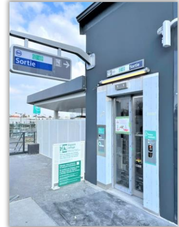
Mise en place de 2 ascenseurs de part et d'autre du passage sous voies et 2 EM d'accès Voie 2 direction Paris
