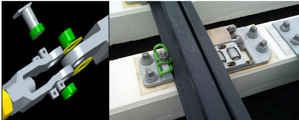
Figure 25 : Roulement de tringle et rouleaux d'aiguille sans lubrification
