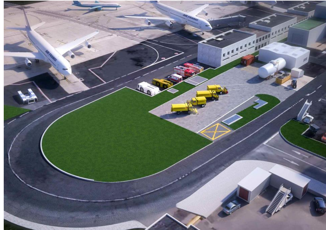
Figure 43 : Exemple d'une émergence limitée à des grilles et des trappes au sol -OA1 ORLY sous le parking des dégivreuses
