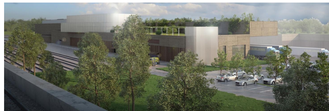
Figure 110 : Vue sur le SMI depuis le viaduc phase AVP-a.
