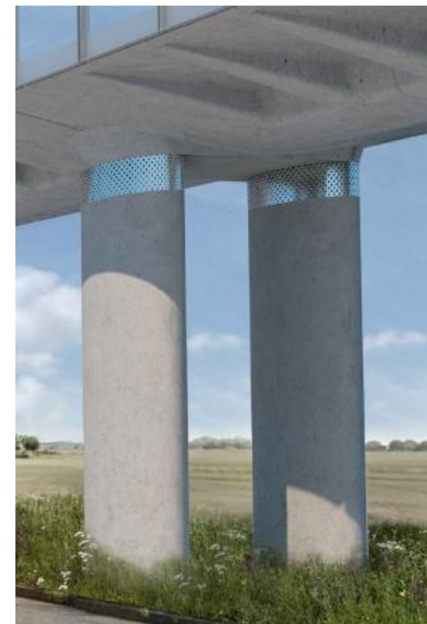
Figure 46 : Pile à fûts doubles. Exploration architecture mai 2019
