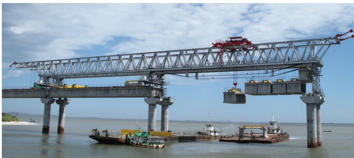
Figure 66 : Exemple : (Pont de Laguna, État de Santa Catarina, Brésil)
