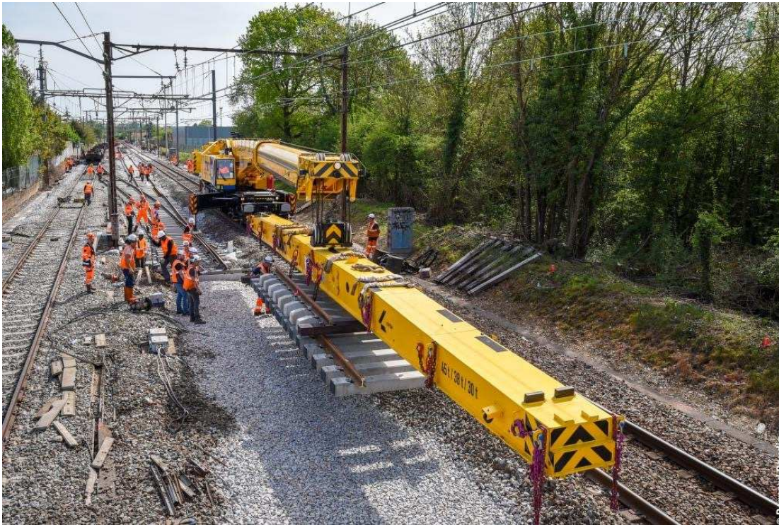
Remplacement d'aiguillages à Brétigny
