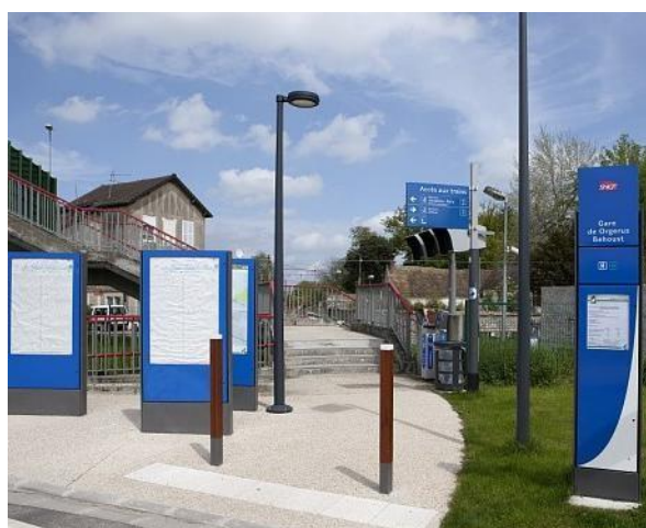
Information statique sur l'offre de transports en commun dans un PR au sol
