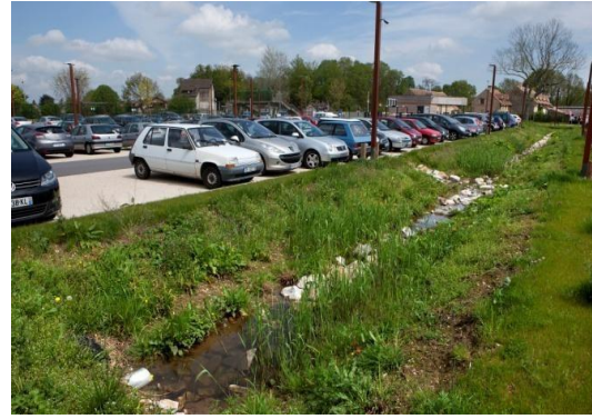
Traitement de qualité des aires de stationnement Noues de récupération des eaux pluviales
