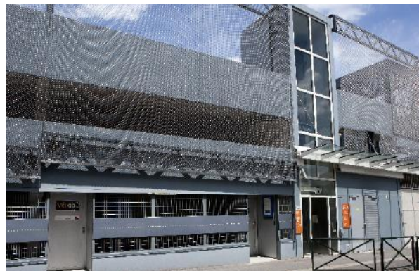
Consigne intégrée dans un PR en ouvrage
