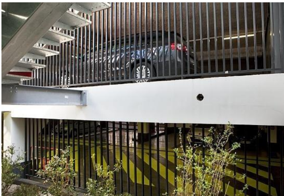
Dispositif de façade laissant passer la lumière
