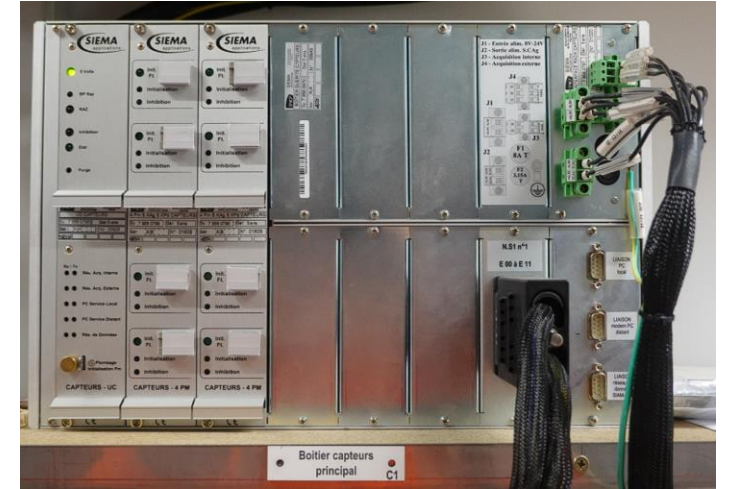
Modules de télésurveillance et enclenchements informatisés
