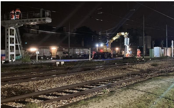
42 Nouveaux portiques installés
