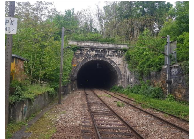
Tête du tunnel côté Paris
