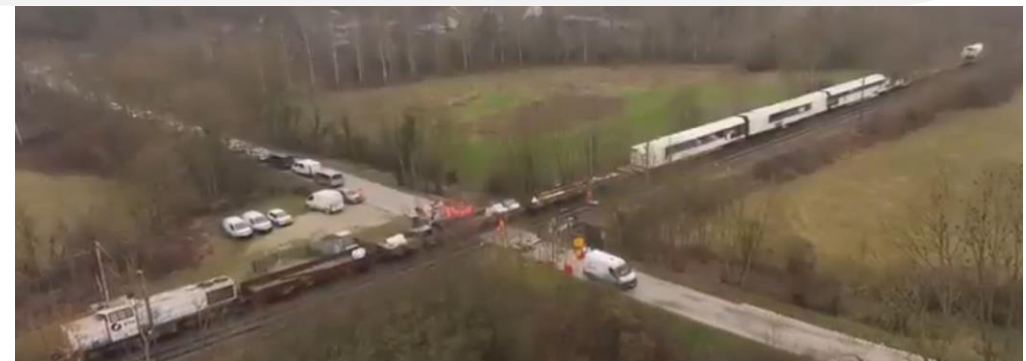
Train usine lors d'un chantier en Champagne Ardennes
