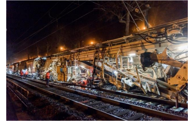
Train usine de renouvellement de voie
