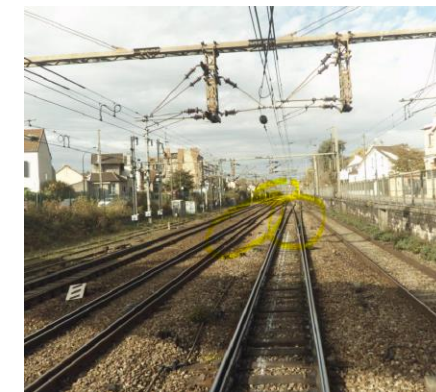
Appareils de voie à remplacer en sortie de Maisons Laffitte
