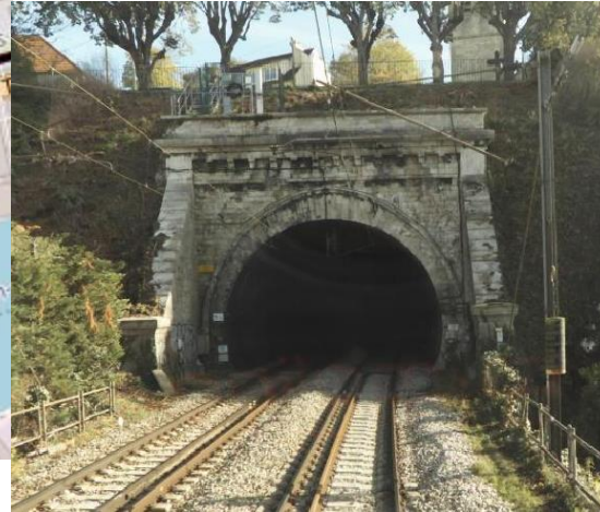
Tête du tunnel côté Mantes
