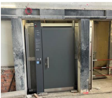
Pose en cours à Bellevue
