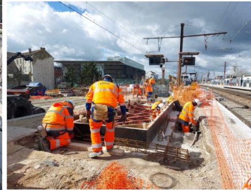
Rehaussement des poutres des escaliers fixes
