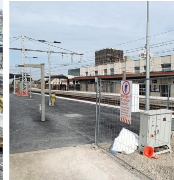
Enrobés provisoires et sécurisation des emprises
