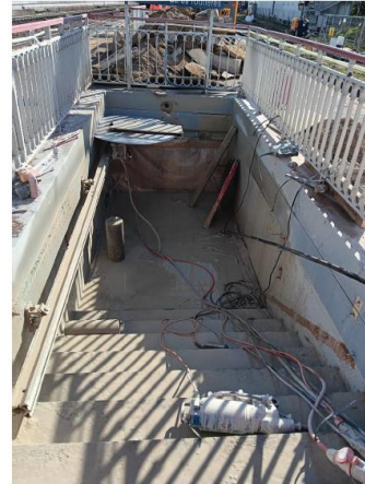
Reprise des poutres existantes des escaliers fixes
