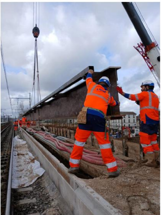
Pose de la structure primaire du tablier provisoire
