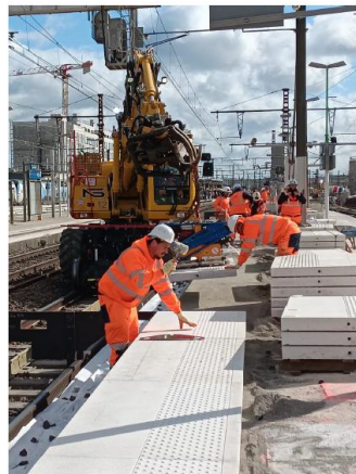
Pose de dalles d'éveil
