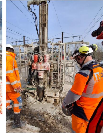
Forage pour le futur passage souterrain
