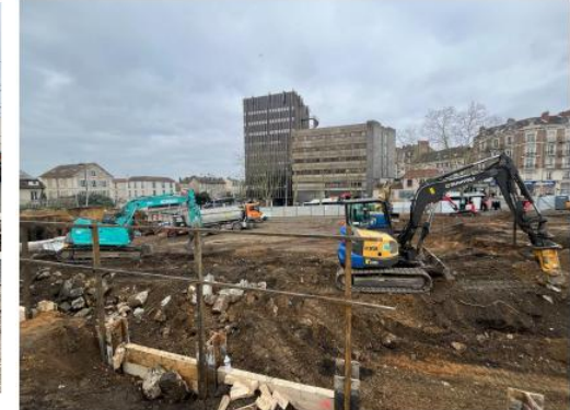
Fondations et terrassement de la zone de préfabrication du passage souterrain
