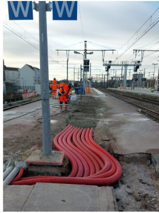
Mise en place des fourreaux de réseaux neufs
