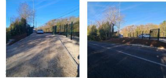
Renforcement sur Garennes : finalisés
