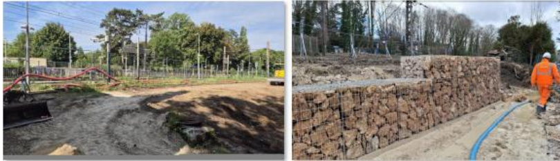
Sous-station Bois le Roi : finalisés
