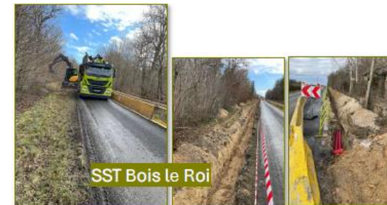
Travaux Enedis de raccordement au réseau électrique : SST Bois le Roi 60%, Thomery 95%, Souppes 50 %
