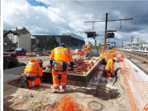
Rehaussement des poutres des escaliers fixes
