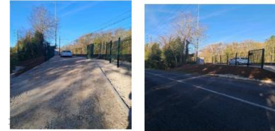
Renforcement sur Garennes : finalisés
