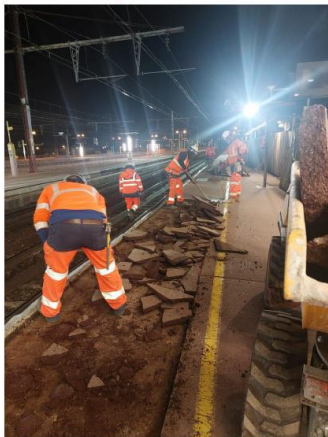
Dépose des enrobés existants de quai
