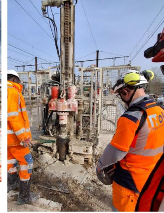
Forage pour le futur passage souterrain
