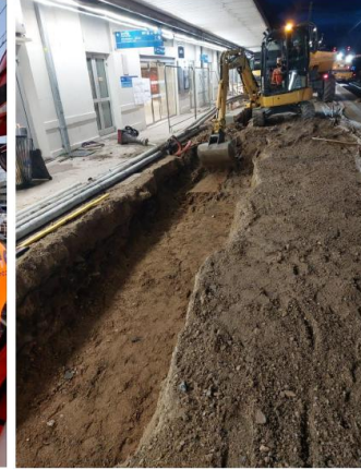
Terrassement de fondations
