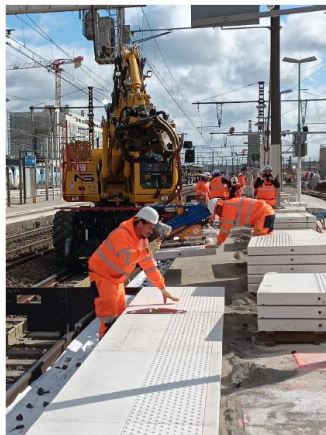
Pose de dalles d'éveil
