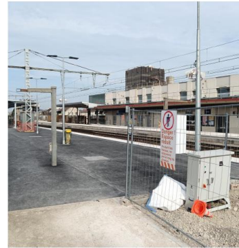
Enrobés provisoires et sécurisation des emprises
