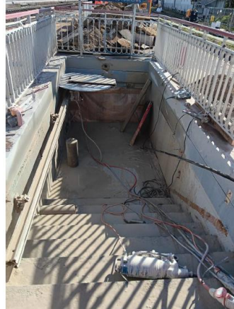
Reprise des poutres existantes des escaliers fixes
