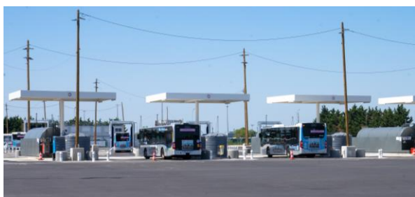
AVITAILLEMENT A LA STATION-SERVICE DU DEPOT BUS & CARS ACCREDITES D'AULNAY-SOUS-BOIS
